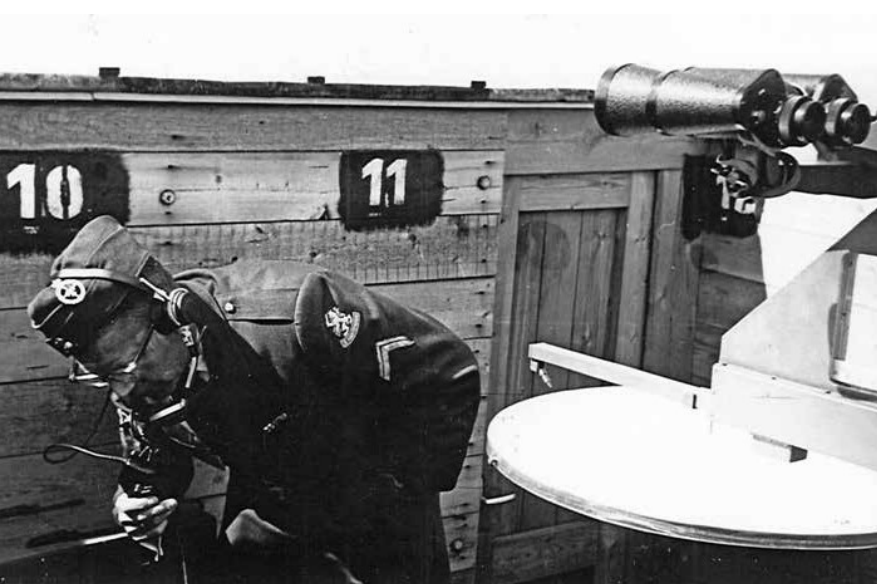
Instructeur Jan de Haas op een van de posten in de Kop van Noord-Holland waar hij les gaf (vermoedelijk Oudeschild op Texel). Rechts het luchtwachtinstrument. De cijfers op de houten borstwering zijn klokuren en dienden als hulpmiddel voor snelle richtingbepaling. De deur in de hoek leidt naar de schuilnis.
