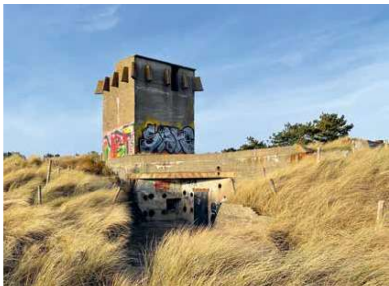
Luchtwachtpost 4N4 op de Kroontjesbunker in Huisduinen. Deze van oorsprong Duitse torenbunker (FL250 Flakgruppenkommandostand) uit de Tweede Wereldoorlog is tijdens de Koude Oorlog hergebruikt als luchtwachtpost door toevoeging van een extra borstwering en schuilnis. Het is de enige luchtwachtpost op een Duitse bunker die nog bestaat. Bovenop de bunker is de Duitse situatie teruggebracht waardoor er uitkijkposten uit twee perioden te bezoeken zijn.
