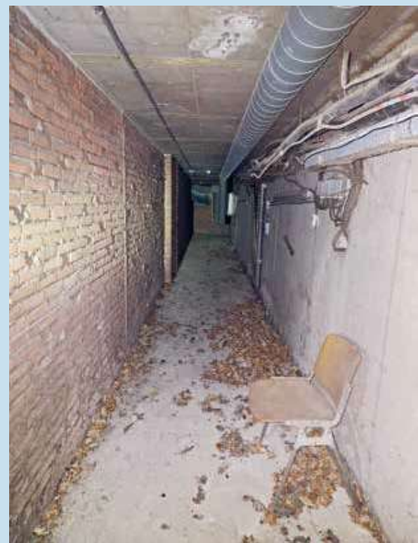
De inblaasgang rondom de parkeergarage.
