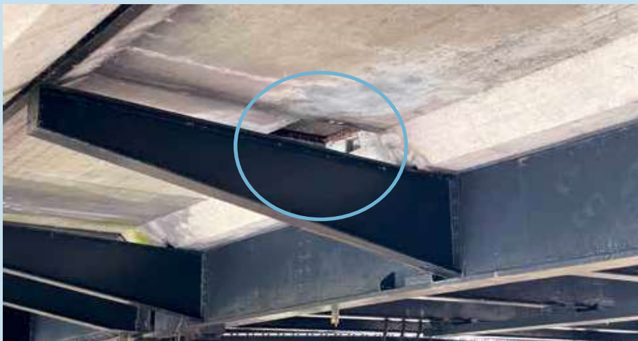
Onder de Friesebrug is de locatie waar het luik zat en het plateau hing nog zichtbaar. Het plateau is verwijderd.
