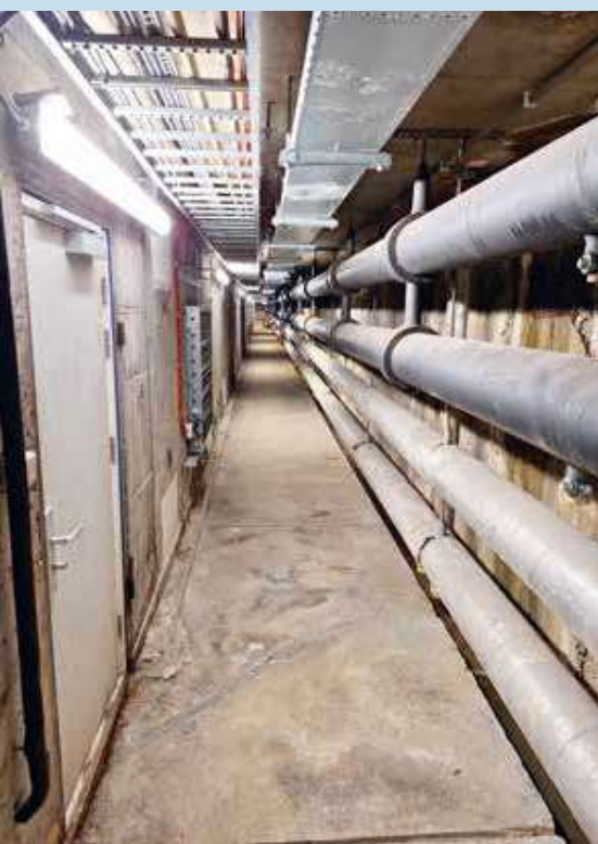
De recirculatiegang rondom de parkeergarage.
