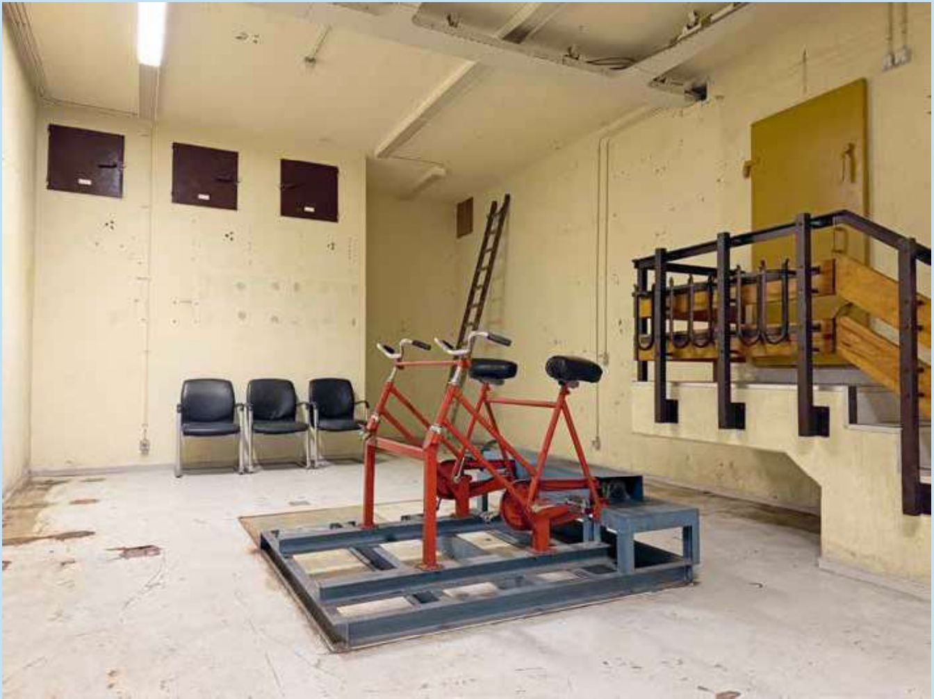
In de luchtbehandelingsruimte resteren nog de twee trapfietsen, maar ook de houders voor perslucht flessen, de trap, stalen deuren en op de achtergrond drie luiken naar de wateropslag tanks.
