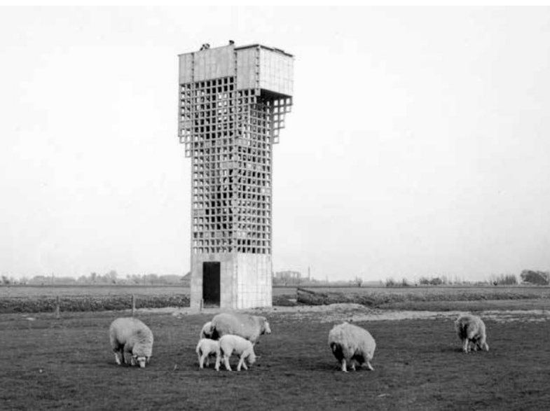
Luchtwachttoren 4P3 Barsingerhorn kort na de bouw in 1954. Een betonnen raatbouwtoren van een veel voorkomend type 11.64 (ruim 13 meter hoog), naar ontwerp van architect Marten Zwaagstra. In 1977 is de toren gesloopt; het fundament bleef in de grond achter.
