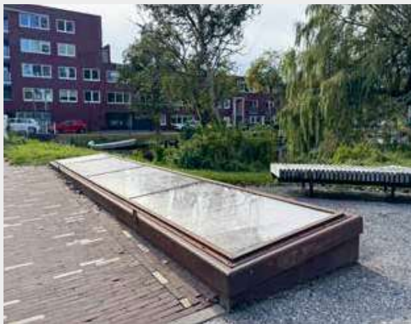
De Wolfsbrug heeft vergelijkbare aanpassingen als de Zoutkeetbrug met lichte tegels in de brug die de sponning toegankelijk maken. Bij deze brug heeft een kunstenaar de bak voor de schotbalkken recent opnieuw vormgegeven.
