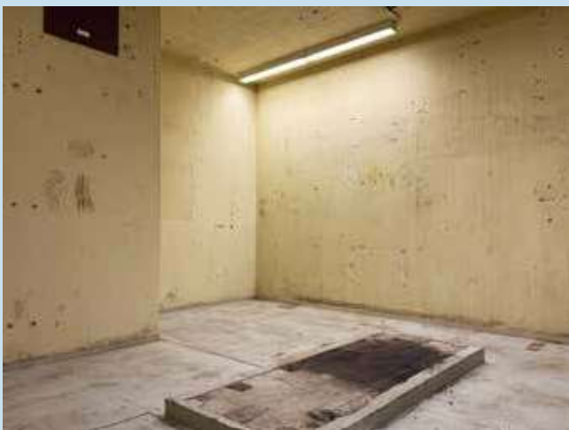
De aggregaatriimte (N.S.A.) waar het noodstroomaggregaat stond.
